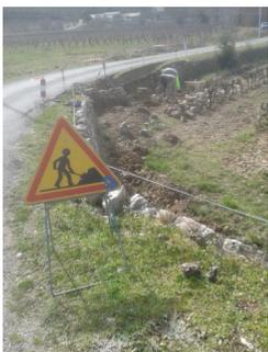
Chemin de la Plaine Quartier St Loup une semi-remorque allemande désorientée par son GPS avait en « manœuvrant » partiellement démolit le mur de soutènement du chemin, endommagé les enrobés et embouti le local poubelles. A ce jour les enrobés sont refaits à neuf, le mur reconstruit et les locaux poubelles réhabilités.
