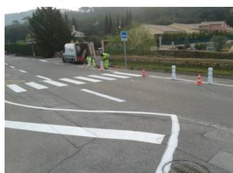
Sécurité routière ensuite avec la reprise de la signalisation horizontale de la rue Aragon route de Brignoles ; avec un point particulier sur la sécurisation de l'arrêt de bus scolaire angle rue de Résistance : reprise totale de la signalisation horizontale, déplacement des arrêts de bus, mise en place d'un passage protégé ainsi que d'un passage piétons dirigé à l'aide de balises blanches réfléchissantes. Sur ce même point vérification de l'éclairage public.
